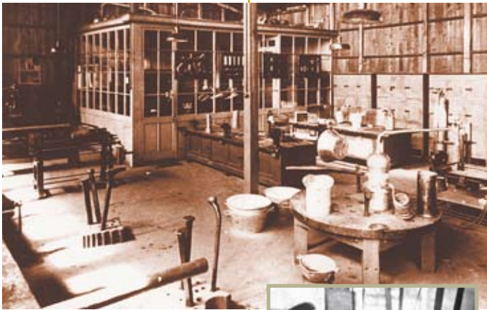
EN POCO tiempo los talleres se hicieron estrechos, lo que obligó a construir un nuevo edificio.
