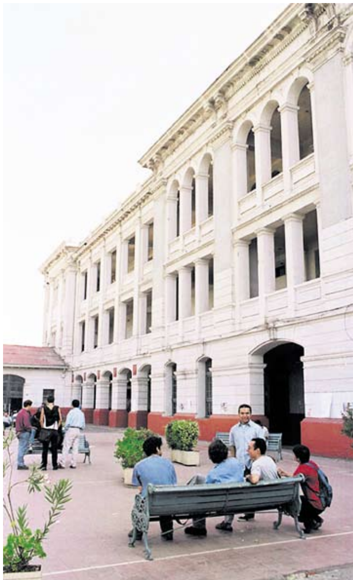
EDIFICIO que alberga a las Escuelas de Periodismo y Psicología.
